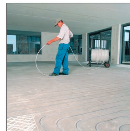
Het aanbrengen van de verwarmingsbuizen in de sleuven.
