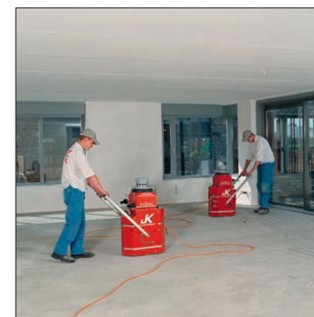
Met behulp van de gepatenteerde slijpmachine wordt een nauwkeurig sleuvenpatroon aangebracht.
